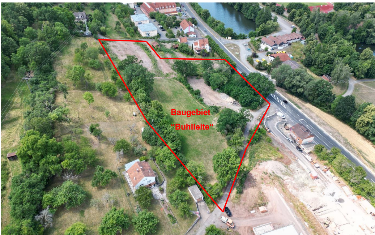
Abbildung 1: Luftbild vom Baugebiet „Buhlleite“
